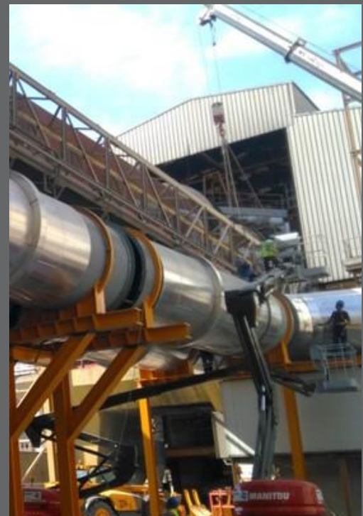
SUBSTITUIÇÃO TÉRMICA EM SOUSELAS
